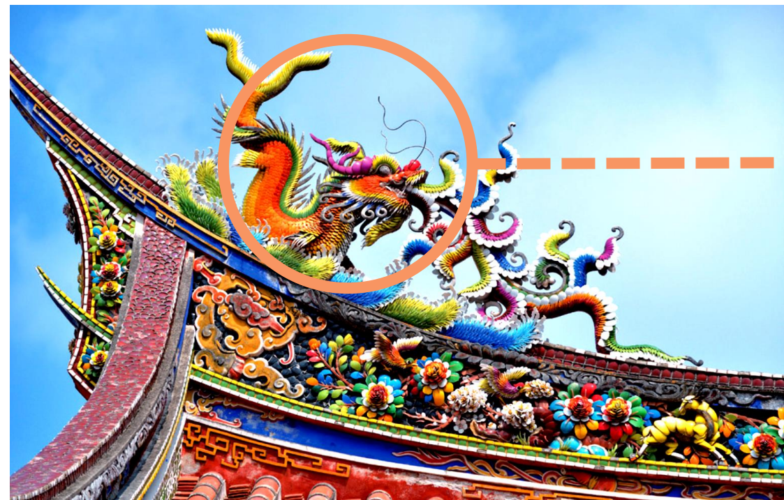
▶ 圖12 臺北市大龍峒保安宮之屋脊剪黏，可從龍鱗一片一片窺見黏的精巧工藝，在陽光照射之下顯得熠熠生輝。
