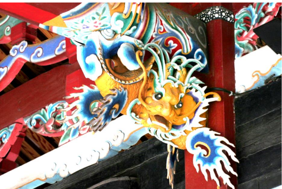
▲ 圖21 臺北孔廟的雀替
