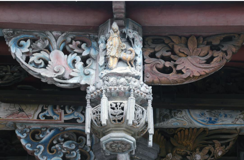
▼ 圖24 新莊慈祐宮的吊筒雕刻與雀替相映成趣。
